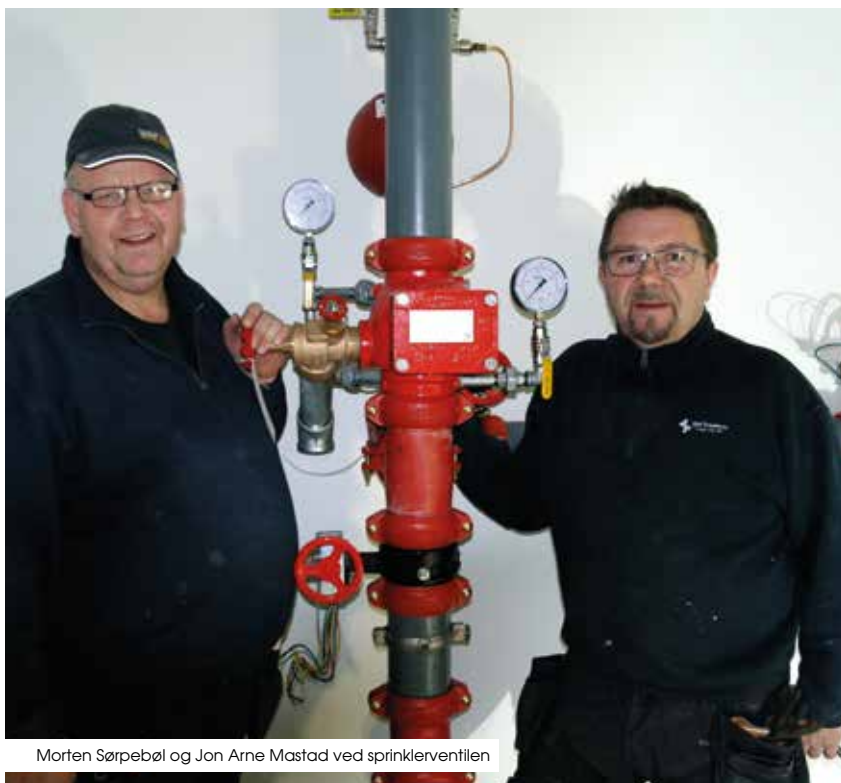
Sprinklerventil
