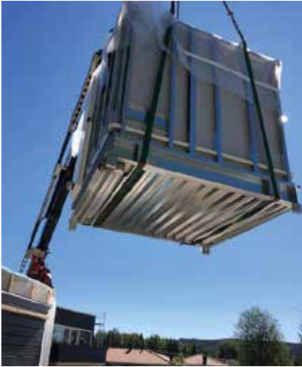
Spennende når ferdige badrom heises på plass
