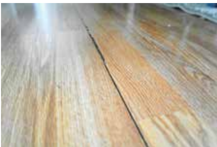
Gulv før renovering
