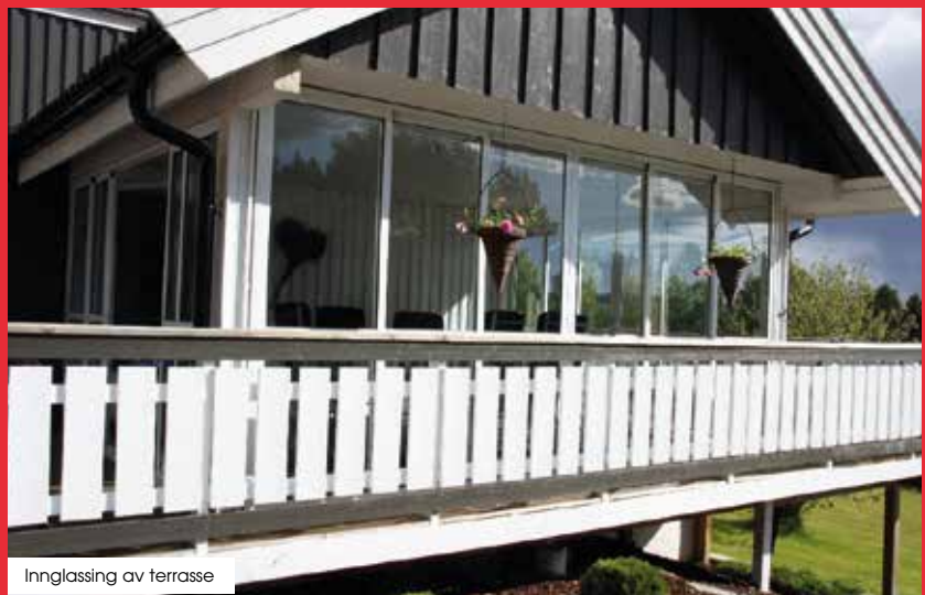
Innglassing av terrasse
